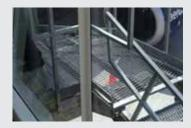
El piso antiderrapante "Grating" representa una alternativa económica a la rejilla electro-soldada, debido a que se elabora a partir de placa de acero de hasta 5/16" y no tiene soldaduras ni costuras.
